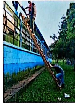
Foto 2: Implementando canales y bajadas de agua pluvial
