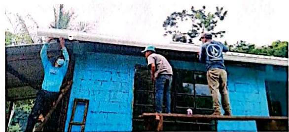
Foto 6: Implementando canales y bajadas de agua pluvial,
