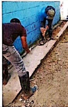
Foto 3: cambiando el piso de interior y exterior
